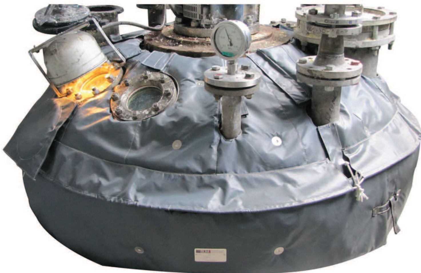
Na zdjęciu: pokrowiec termoizolacyjny SUM Poland odporny na agresywną chemię, wodę, olej i zabrudzenia
